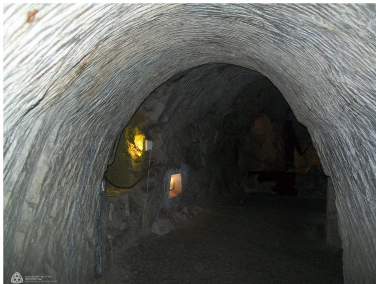
Figure 20. Chełm, gmina miejska Chełm, tunele kredowe, fragment korytarza, stan na 2011 r. fot. Ewa Prusicka [167]
